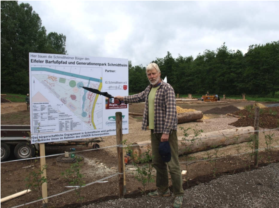
Bild (Autor LAG Eifel): Während Bauleiter Elmar Spicker das Vorhaben erläutert, wird im Hintergrund fleißig am Eifeler Barfußpfad und Generationenpark gearbeitet.
